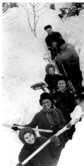
Прокладка траншеи под водопровод. Снизу вверх: Н.И. Гущина, Н.Е. Виснап, Т.С. Симонова.
