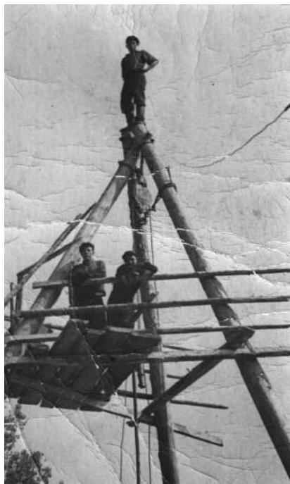
Подъем бурового инструмента.
