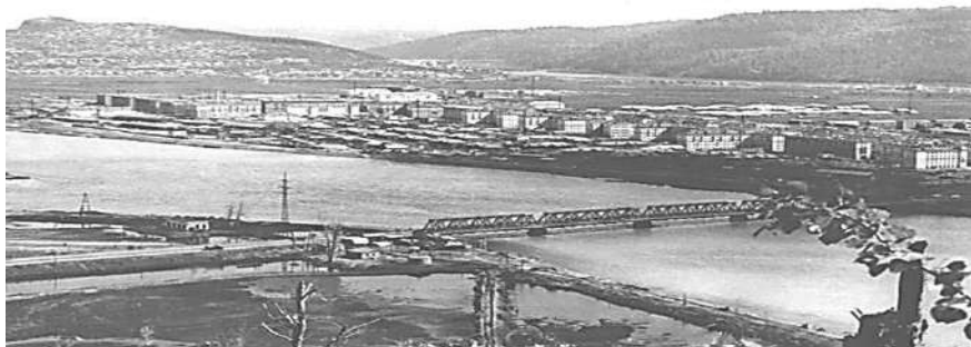
Рис. 22. Слева от моста через У-су насосная станция гидрокомплекса
