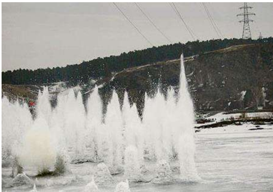
Рис. 14. Подрыв льда на реке
