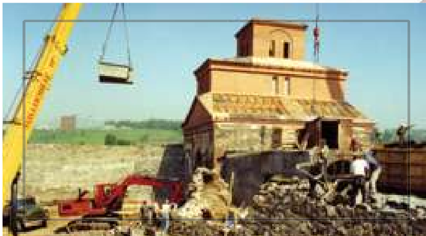
Строительные работы на Кузнецкой крепости. Фото 1998 г.
